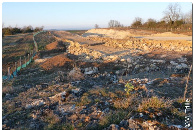
Emprise du chantier sur les pelouses sèches à Lioujas
